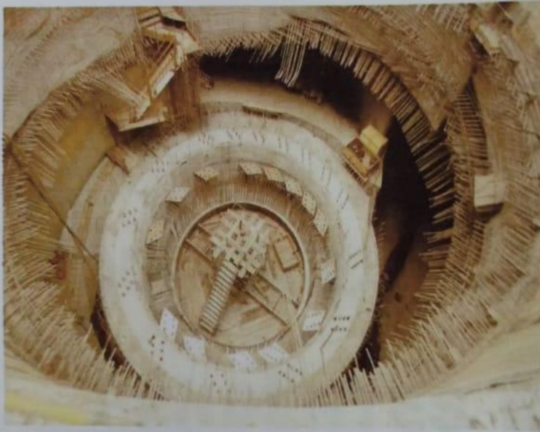
Vista da ancoragem do pré distribuidor posicionada para concretagem no poço da UG 18.
